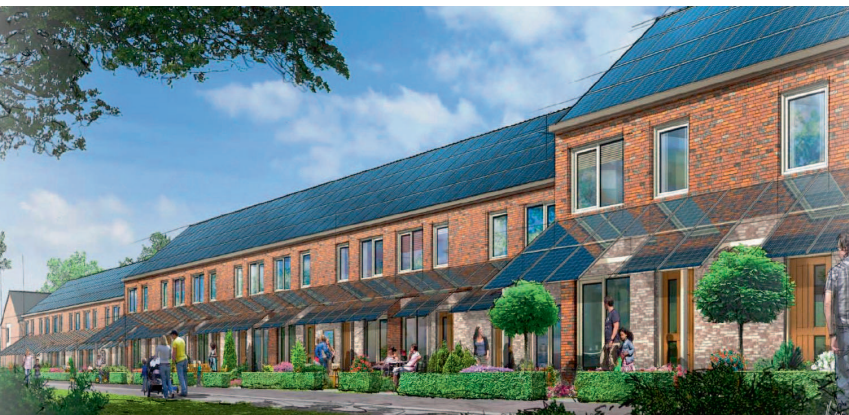
Het huis dat als vlaggenschip wordt bestempeld, heeft een EPC van -0,54.
